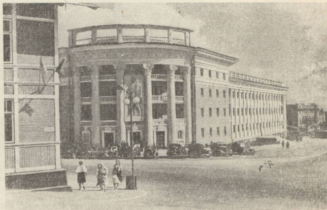
Заново отстраивается Петрозаводск. В строительных лесах стоят многие здания города. При нас закончили строить Северную гостиницу. Посмотрите, какая она красивая!
